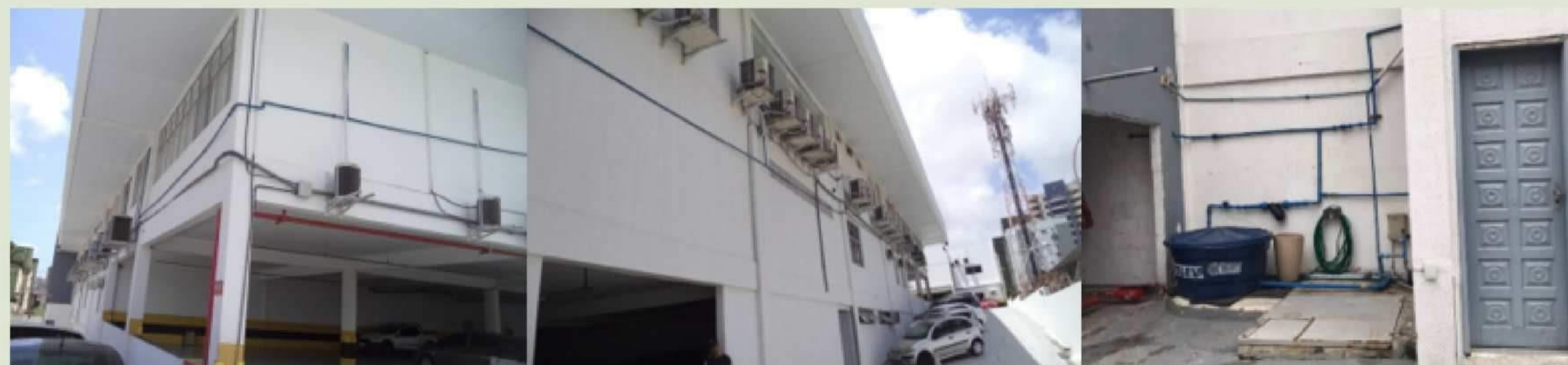
Fig. Sistema de coleta e armazenamento de água dos condicionadores de ar para reuso no prédio da sede do SEBRAE/RN em Natal.
